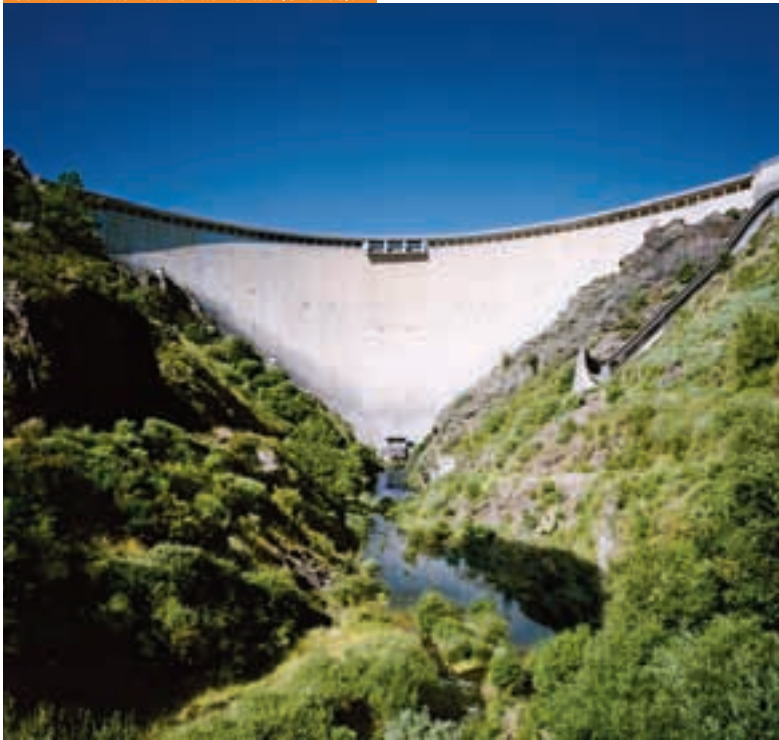
Central hidráulica de Las Portas (Orense).
